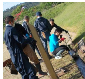
排水路の泥上げ
